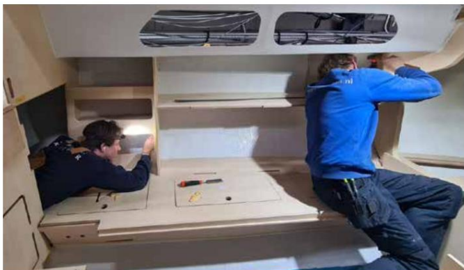
Montering av interiøret
