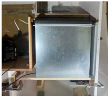
November 2025: Installasjonen tar form. Kjøleren monteres. Skummet mellom laminaten er tydelig synlig i skapet. Foto: Jasper Sterrenburg.
